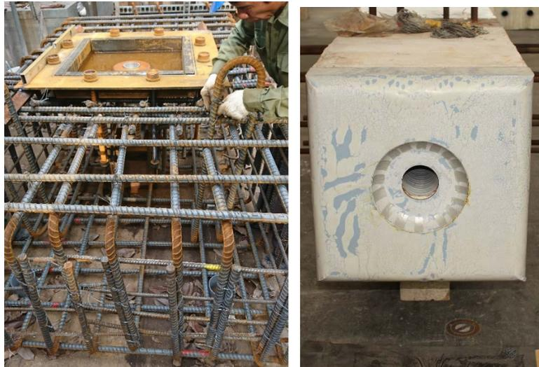
圖 2 基礎鋼筋籠及包覆鐵管之柱底
